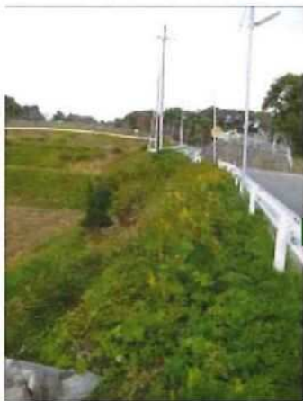
西側連絡道の法面の草刈(前)
