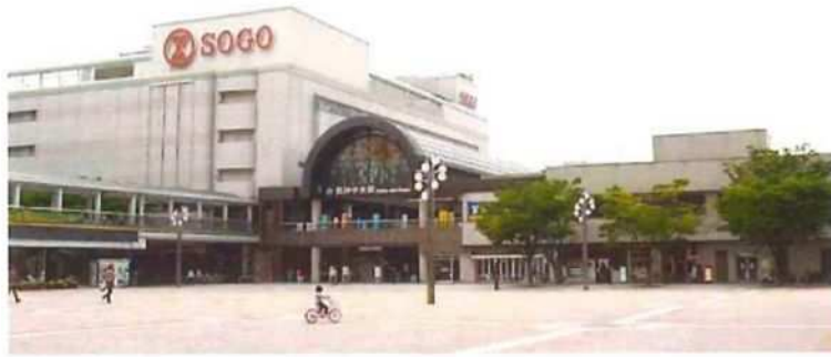
地下鉄西神中央駅
