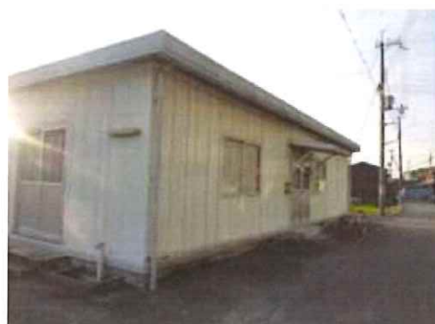
写真. 木幡公会堂 別棟
