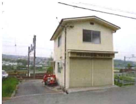
写真. 消防器具庫
