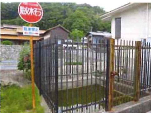
写真. 防火水槽
