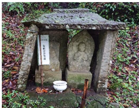
枝折れにより破損した箇所
