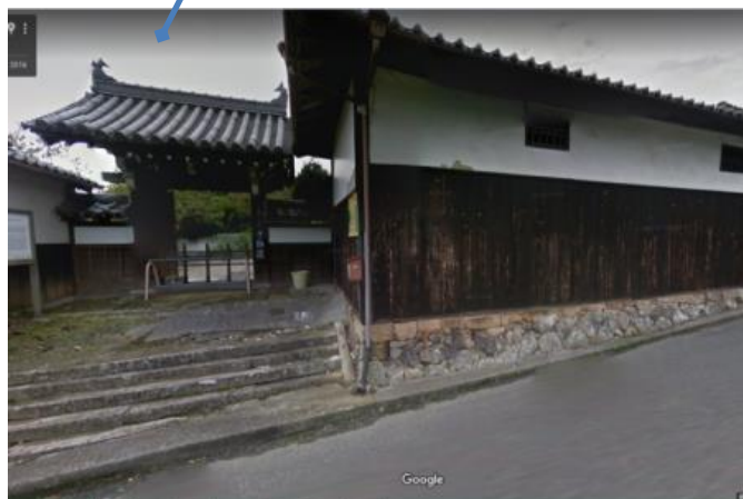
十輪院 土壁・門
