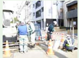
常に質の良い施工を心がけ、市民の安心安全な生活を支えるインフラ整備をしています。
