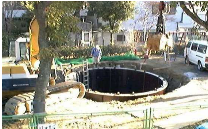
図 公園での耐震性防火水槽の設置
