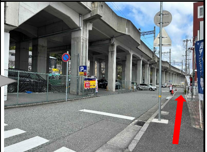
④高架下沿いをまっすぐ進みます。
