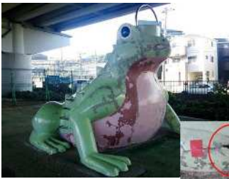
築40年以上経過したCO遊具 （老朽化・安全基準不適合のため撤去）
