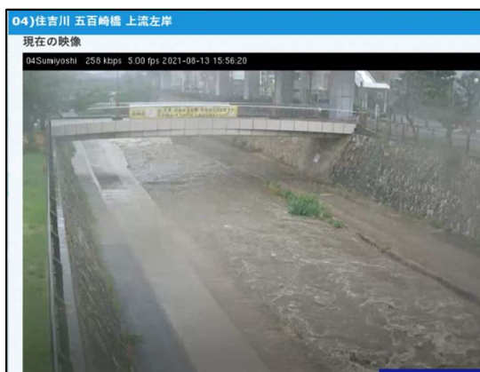
例. 河川モニタリングカメラシステム
