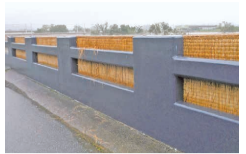
西日本豪雨の際の畳堤。畳は横191cm、縦95cmの本間サイズで、現在は全て自治会等の倉庫で管理されています。
