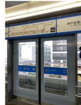
ホームドア 行き先やGTFS連携による電車到着時刻の案内(予定)
