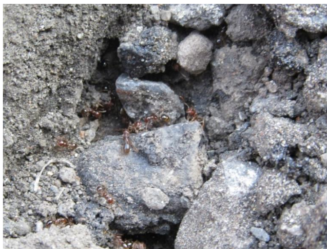
舗装亀裂部で発見されたヒアリ
