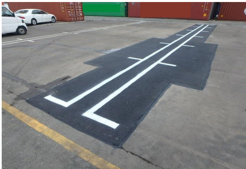
神戸港における舗装打換え事例
