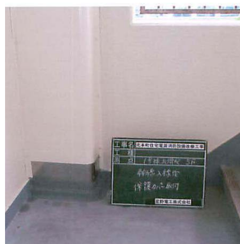
ケーブルラックカバー取付完了
