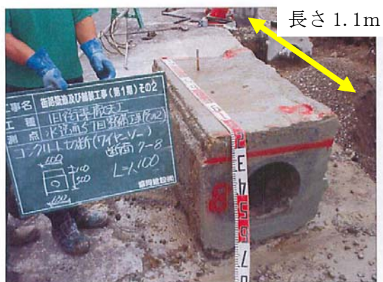
カットした街渠
