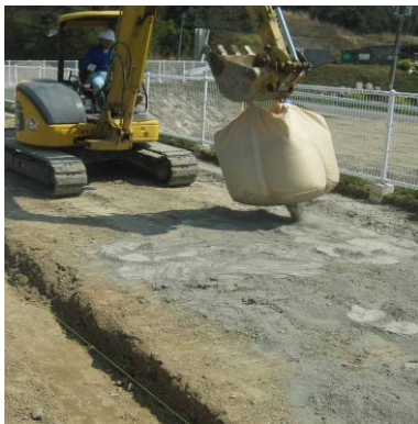
地盤改良状況
