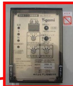
地絡保護装置(受変電設備内にあり)
