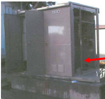
本施設の受変電設備の工事中の状況
