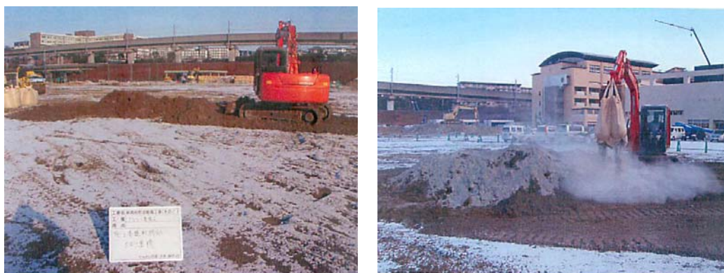
グラウンド内の地盤改良状況
