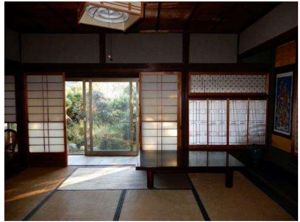
床の間南側は、香の図組障子と蜀江（しよっこう）文様の欄間で構成された平書院とし、穏やかな光を取り込んでいる。
