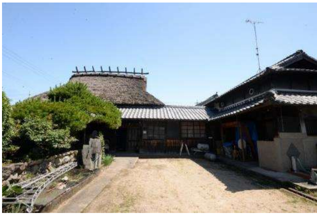
広い玄関アプローチ。主屋東側に付属棟が見えるが、入母屋造瓦葺二階建てであり、北側にある土蔵と同様に丸窓を設け、納屋でありながら意匠性が感じられる。
