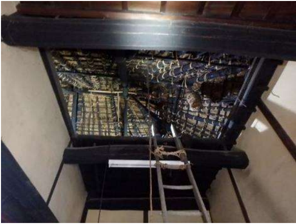
玄関土間より小屋裏を見上げる。小屋裏の叉首、屋中、垂木には丸太が使われている。木舞下地は仕事が丁寧で、整然と細かく組まれている。
