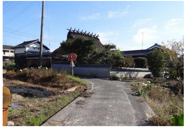
西側から見る。塀沿いに北側から周り込み、主屋へアプローチする。
