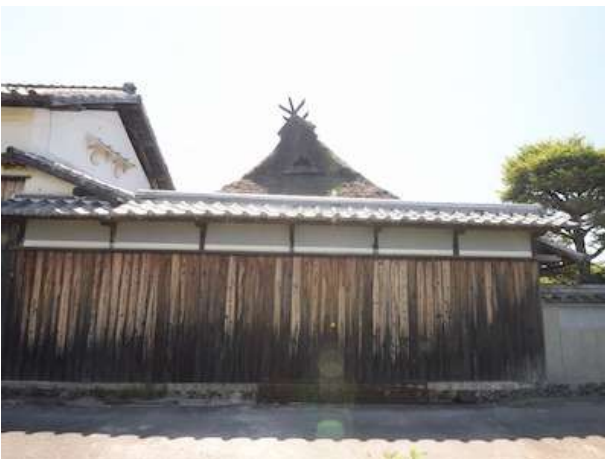
西側の板塀越しに茅葺屋根の破風が見える。塀の水平ラインと相まって、西面の顔的役割を担っている。
