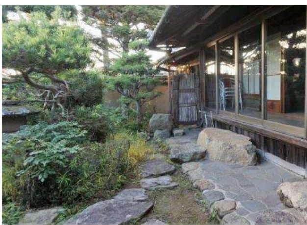
玄関より西方向を見る。庭からの飛び石が立派な沓脱石につながる。西側には袖垣を境界として腕木門が設けられている。
