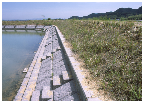
地元産の子ガヤを植栽したため池堤体
