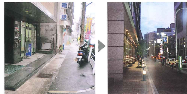
震災前の栄町通歩道
