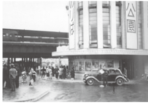
阪急電車の三宮延伸と 阪急会館建設 (1937年)
