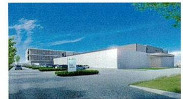
JCRファーマが神戸市西区に建設予定の工場
