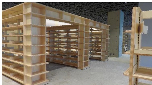
図書館2階 一般書フロア (書架設置工事中)
