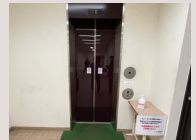
エレベーター
