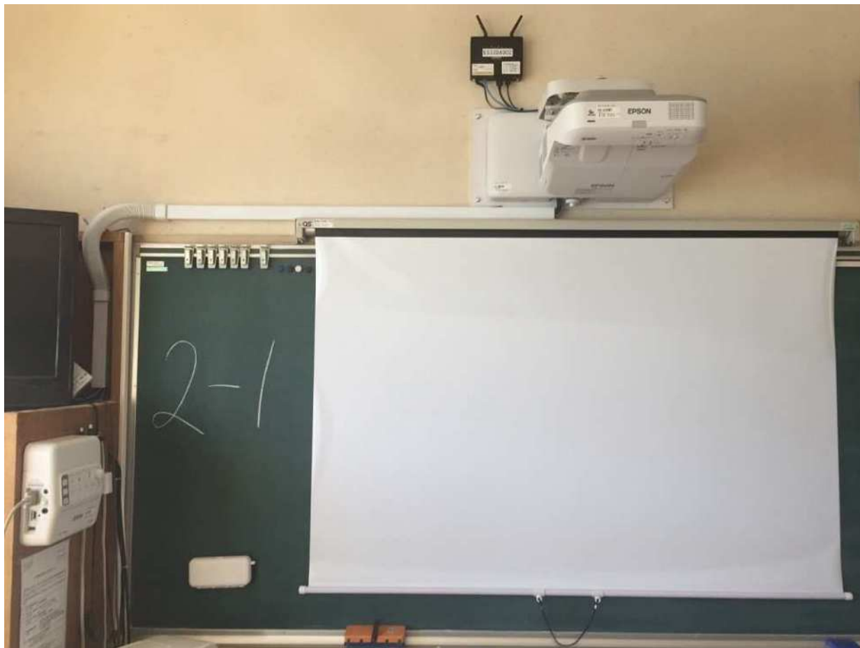
【参考資料4】設置作業例(電子黒板機能付きプロジェクタ, 無線LANアクセスポイント)
