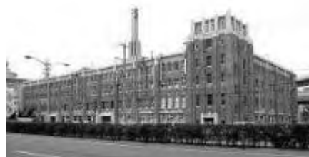
旧神戸生糸検査所（新館）
