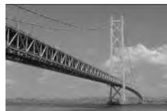
提供：本州四国連絡高速道路(株)
