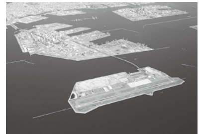
神戸空港島竣工
