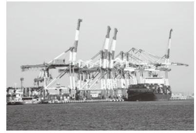
六甲アイランドRC-6/7に22列対応高規格ガントリークレーン3基設置
