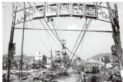
被災した市内の様子
