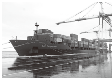
PC-18 大水深化耐震化完了
