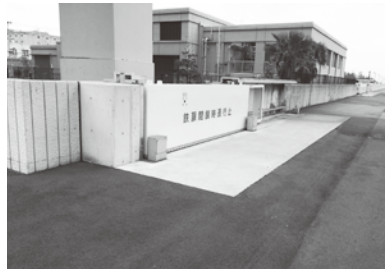
59.8kmの防潮堤及び鉄扉等の完成
