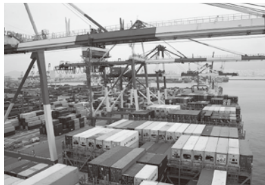
PC-16/17 22列対応高規格ガントリークレーン据付
