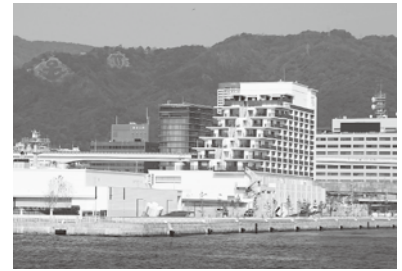
新港第一突堤に「ラ・スイートオーシャンズガーデン」「神戸みなと温泉 蓮」竣工
