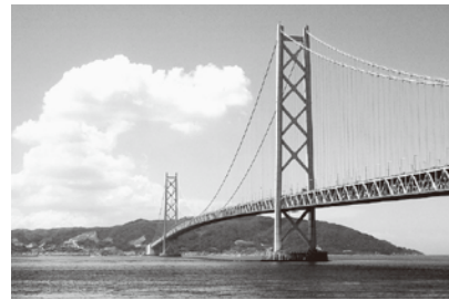
世界最長の吊り橋「明石海峡大橋」開通
