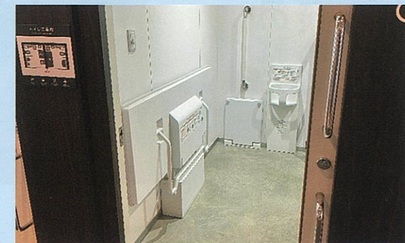
市役所1号館・1階トイレの大型多目的シート
