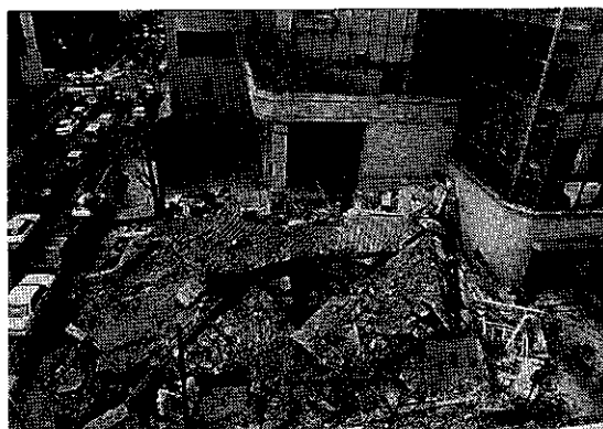
写真2 震災により倒壊した「旧神戸居留地十五番館」
