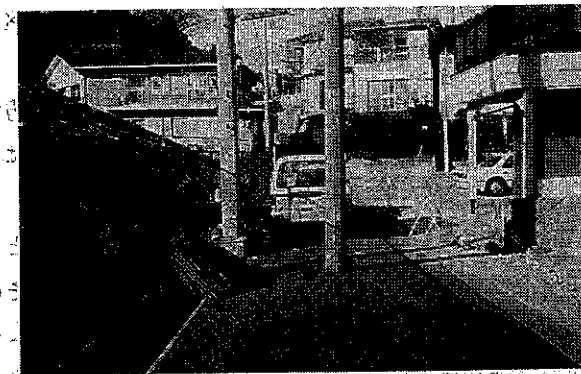
地震によって動いた電信柱
