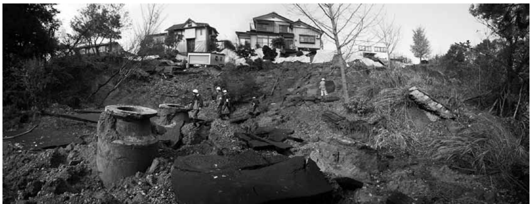
写真-2 中越地震で生じた宅地の被害
