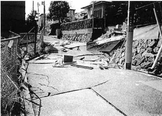
写真-1 阪神・淡路大震災で生じた宅盤の変形 (手前が左に変形)
