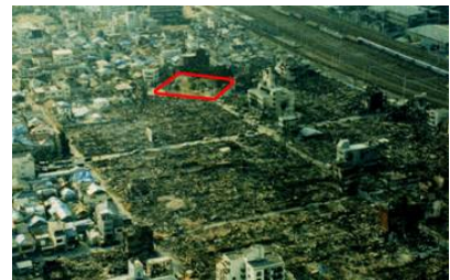
火災の焼け止まり（大国公園）
