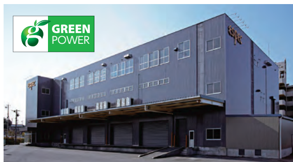
豊田試験所(愛知県豊田市)
