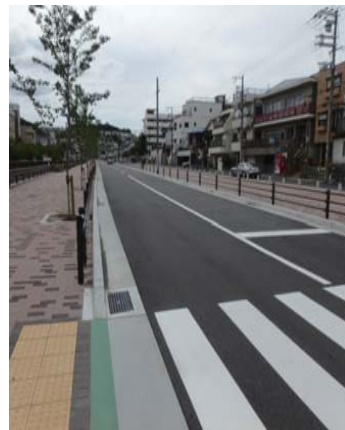
【写真5】新設道路
